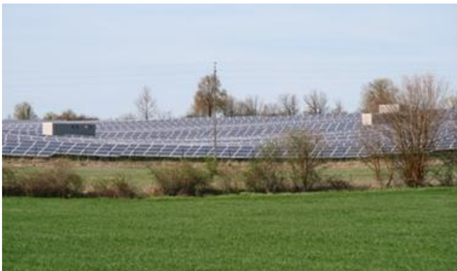
Centrale photovoltaïque de l'Hospitalet - EVEN Conseil
