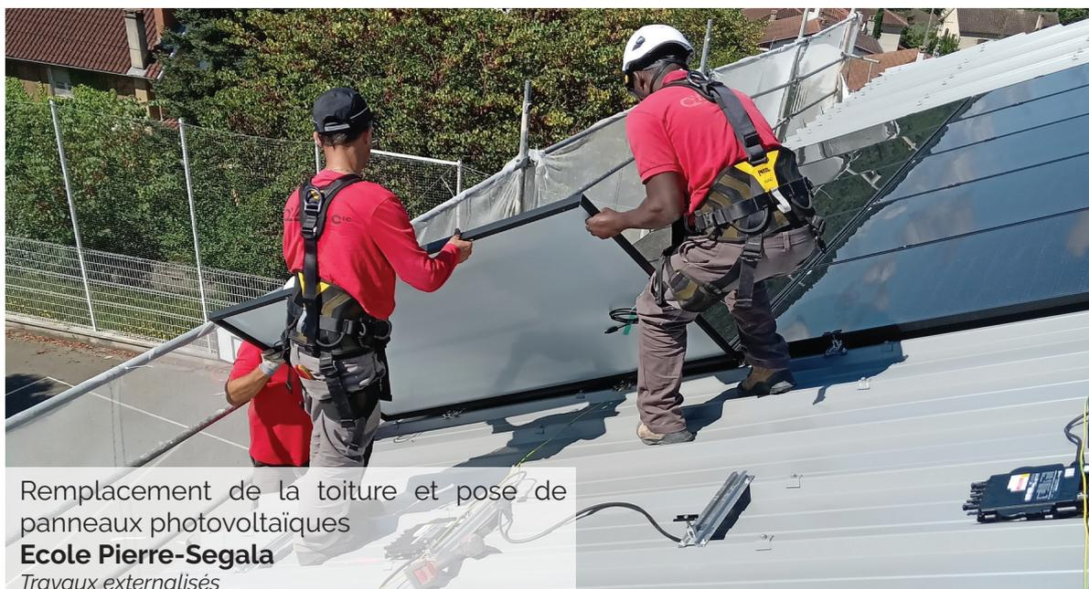
Remplacement de la toiture et pose de panneaux photovoltaïques
