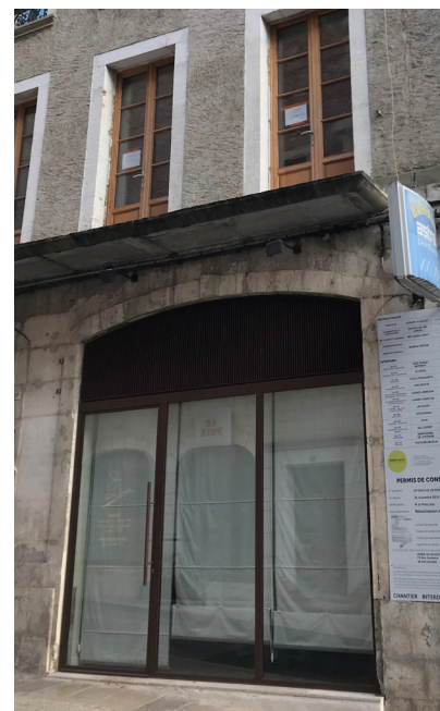
Façade en cours de travaux
