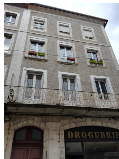
Façade avant travaux
