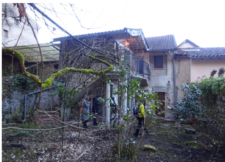
Avant et après travaux
