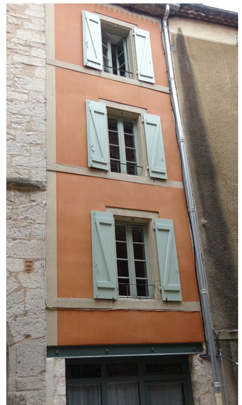
Façade après travaux
