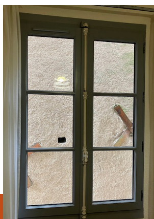
Remplacement des menuiseries par des menuiseries bois performantes
