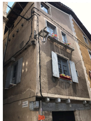
Local vacant avant réhabilitation.
